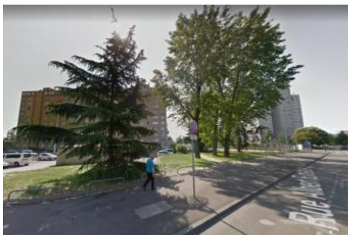
Vue n°2 depuis la rue Albert Einstein vers le sud-est (Source : Google maps)
